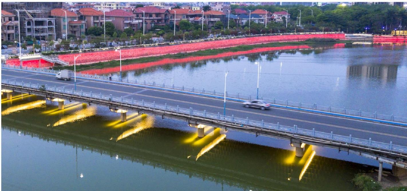
除河道和公园树木，LiteMagic还参与了横沥大桥和南环桥的亮化。两座桥使用了LiteMagic 660W的线形洗墙灯W6304，洗亮桥墩，塑造桥梁建筑结构，3000K的白光光色与彩色变幻的河道相映成趣。
