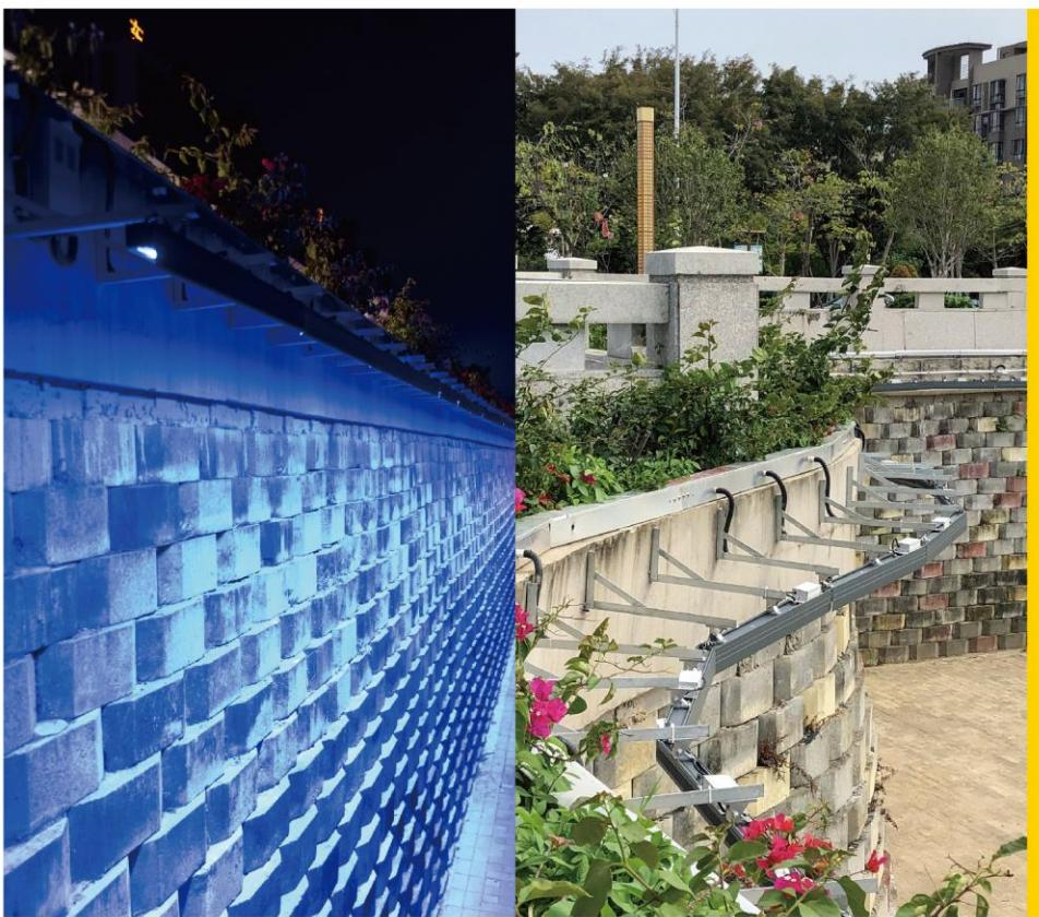
实拍图 | 洗墙灯W6304安装细节&示意图
