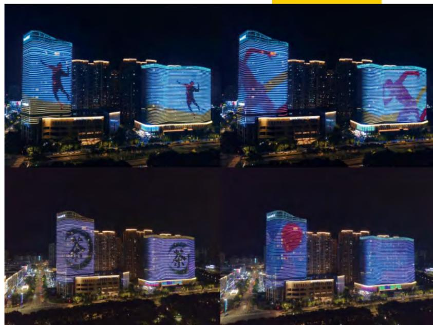
楼体外立面采用流线型弧面勾勒建筑轮廓。点光源MagicStrip X6048被定制为嵌入轨道一体安装。轨道定制为与建筑幕墙接近的颜色,让灯具易于隐藏;X6048配置PC透明光罩和120°透镜,拥有丰富的色彩表现力,能准确展现动画中旖旎变幻的绚丽场景。酒店顶冠处由高低不同的立柱支撑不规则坡面,此处应用的是LiteMagic的投光灯GiantEco F6201,配置功率36W、发光角度8°、光色3000K,分层安装均匀照亮中顶冠结构,暖白光与立面多彩光色形成视觉对比,光影的落差让顶部“SHIMAO世贸”的字样格外瞩目,更贴合了希尔顿酒店在北仑中心城区的地标形象。
